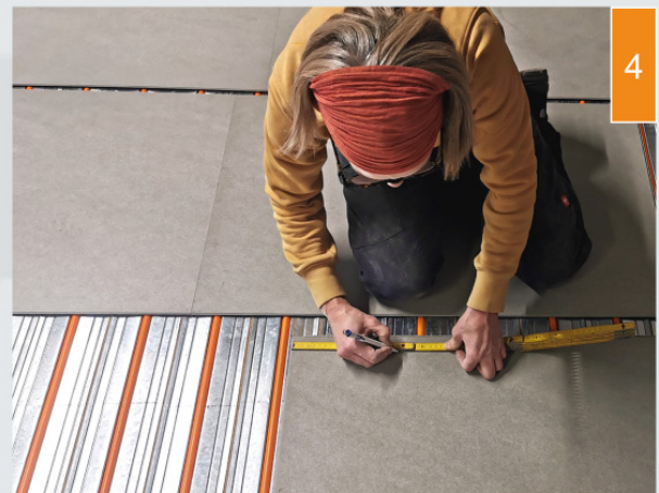
(4) Die Ceralanplatten werden verlegt.
