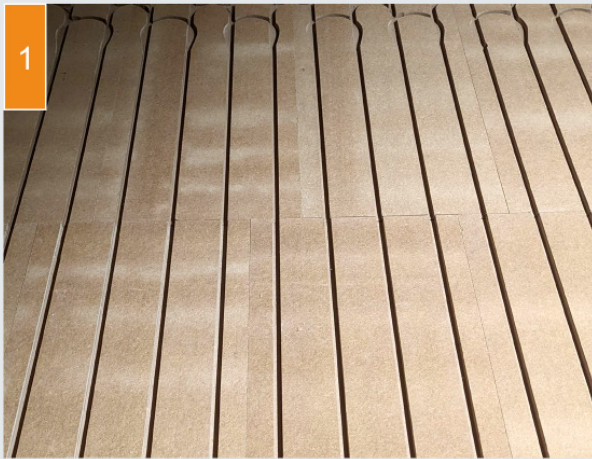
(1) Die Holzfaser-Verlegeplatten werden ausgelegt.
