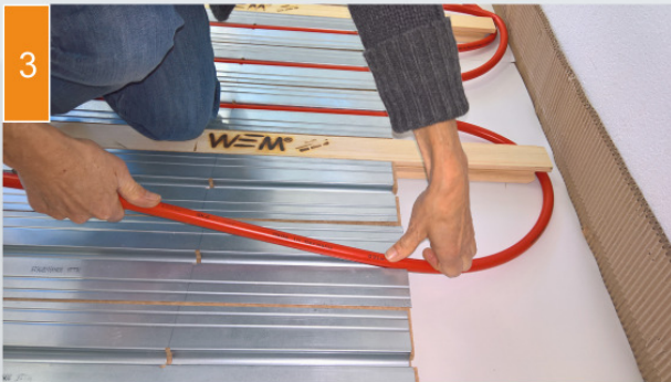
(3) Das Rohr wird in den Wärmeleitblechen verlegt und an den Heizkreisverteiler angeschlossen. Unter die Holzprofileleiste wird am Rand ein Korkstreifen gelegt.
