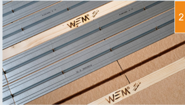
(2) Wärmeleitbleche werden in die Verlegeplatten eingelegt.
