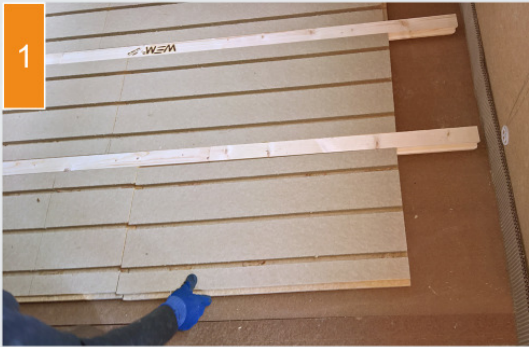
(1) Die Holzfaser-Verlegeplatten und Profileleisten werden ausgelegt.
