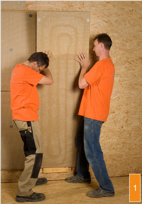
(1) Die Klimaelemente werden aufgestellt ...
